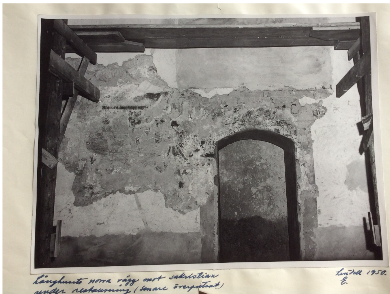
Långhusets norra vägg mot sakristian under restaureringen. Foto: ÖLM 1950
