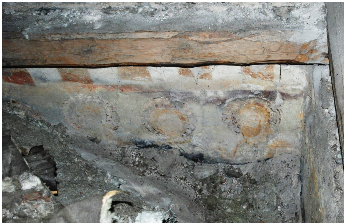
Västra sidan av triumfbågsmuren, södra delen.
