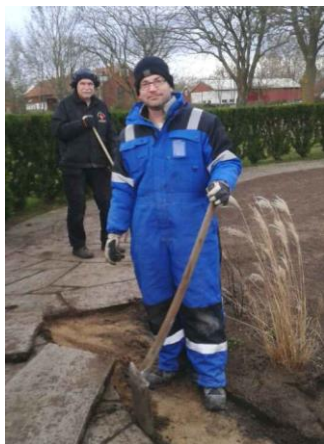
Anläggningsarbeten på Böda kyrkogård. Stefan Sörman och Bertil Wikesjö lägger om kalkstensgången i minneslunden. (Foto:Lennart Sörman)
