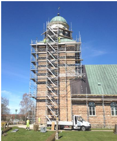
Ställningsbygge Köpings kyrka
