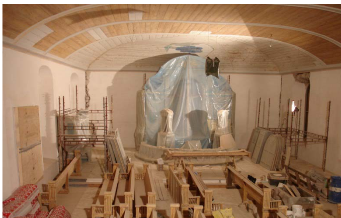
Örslösa kyrka under renovering 2005.
