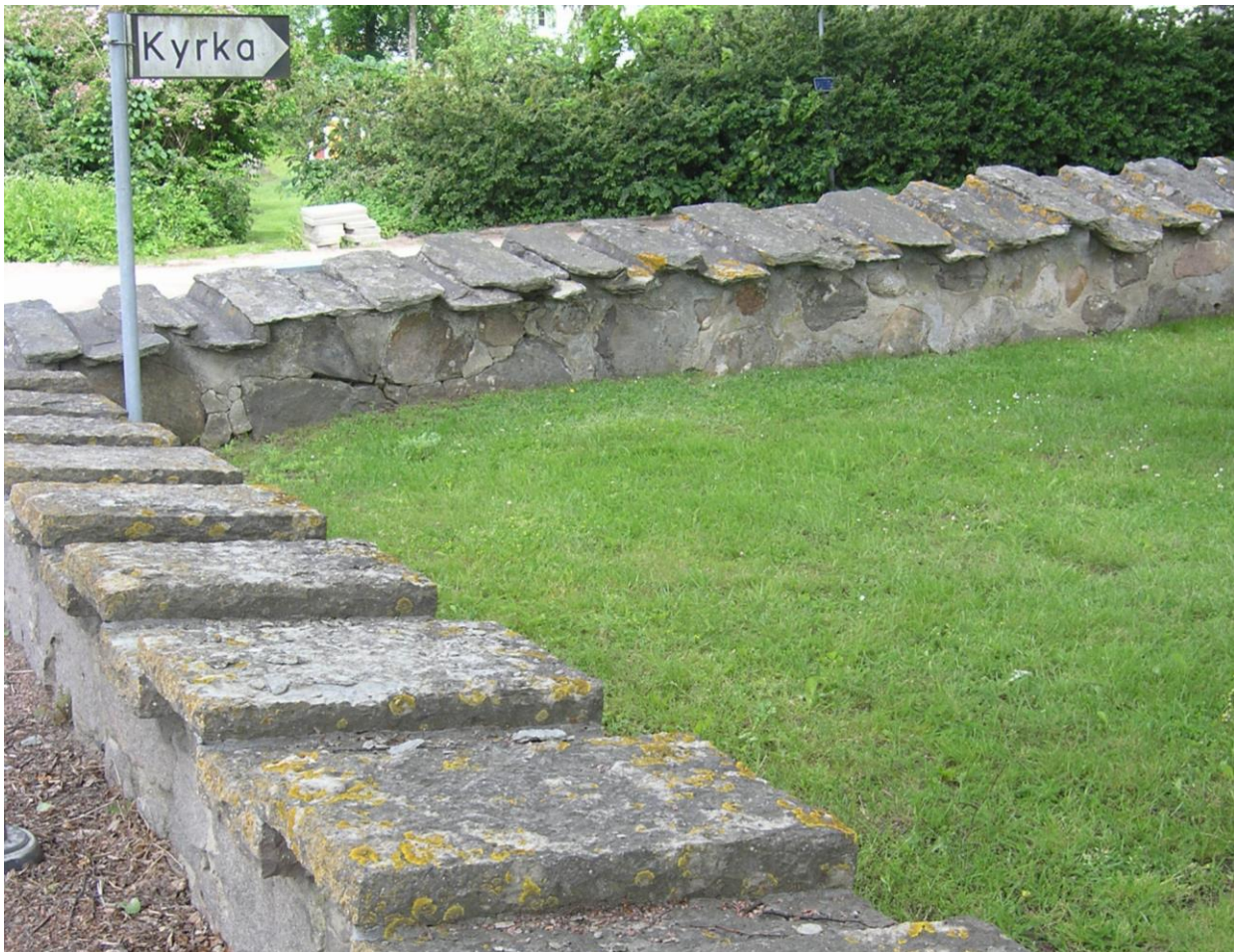
Kyrkogårdsmurens hörn mot sydväst visar hur den låga kvadern mot söder successivt övergår till en högre mur med fogad fältsten och sprängsten av granit samt avtäckt med hållar omlott.
