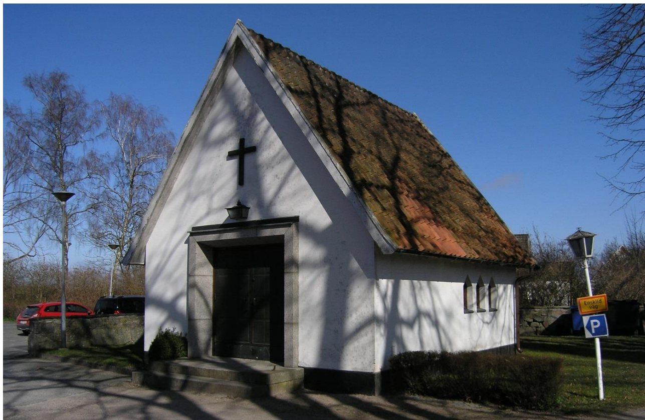
Bårhuset är uppfört 1950 efter ritningar av länsarkitekt Allan Nilsson. Fasad mot söder och öster.
