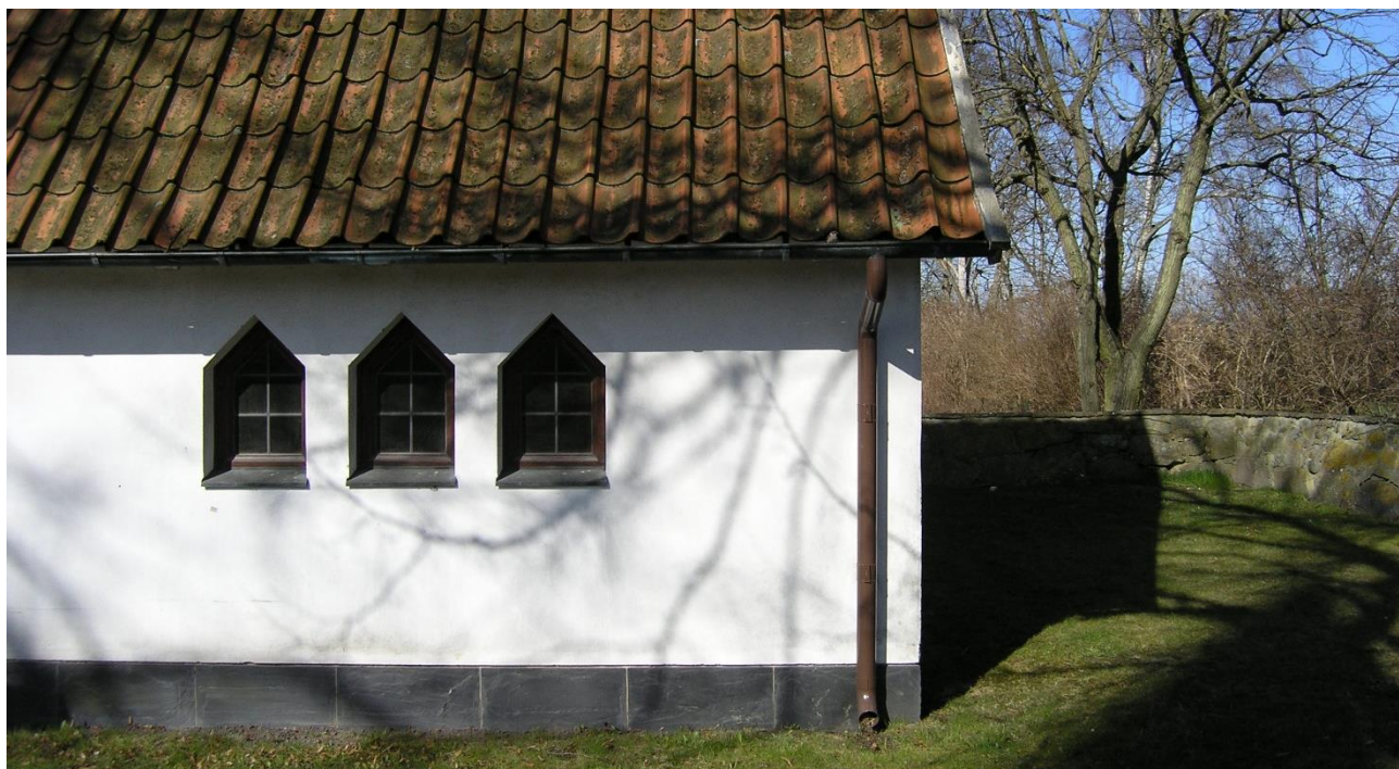
Parti av östra fasaden mot norr med sockel av grå skiffer, putsade och vitmålade väggar, brunmålat träfönster och stuprör.
