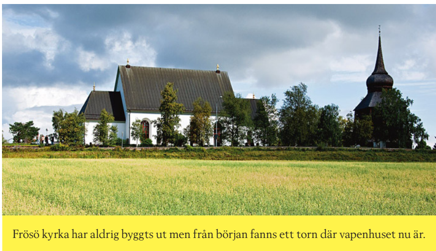
Frösö kyrka har aldrig byggts ut men från början fanns ett torn där vapenhuset nu är.
