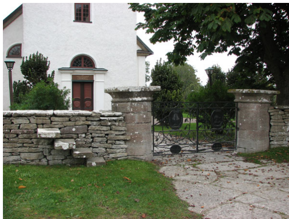
Huvudingången mittför vapenhuset. Notera klivstättan till vänster om grinden (KI Runsten kyrkog 005)
