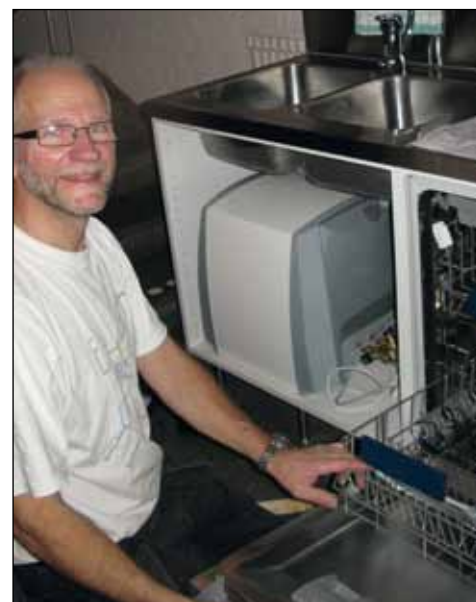
Vaktmästare Jonny slutför installationen av diskmaskinen i Masthuggs kyrkans pentry.
