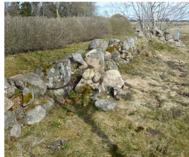
På ett ställe utmed östra muren har stenar hamnat ur läge.
