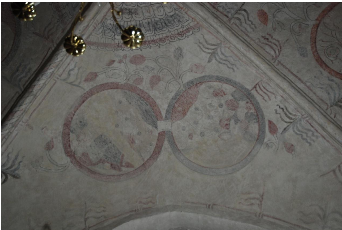
Bild 12: långhusvalvet östra travén, norra valvkappan
