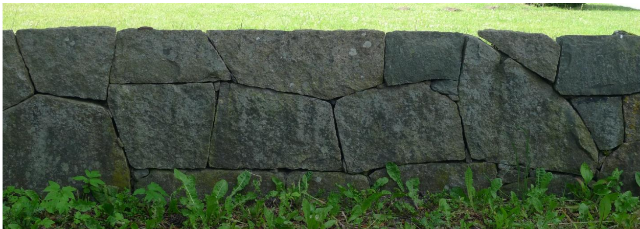
Kyrkogårdens vallmur mot norr är tätt och vackert monterad som kallmur av tuktad sprängsten av grå granit
