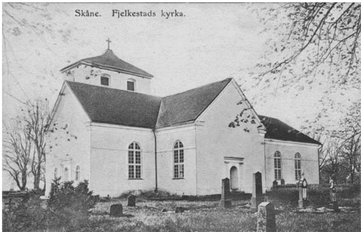
Fjälkestads kyrka omkring 1900 visar den gamla kyrkogården med spridda gravstenar i en ojämn markyta med frodig vegetation och utan markerade gångar. Källa http://www.kristianstadvykort.se/fjalkestad/fjalkestad.htm
