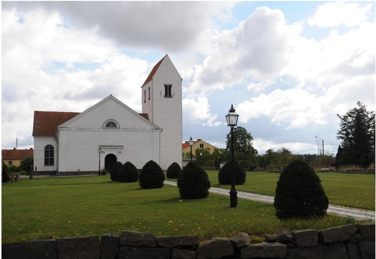
Fjälkestads kyrka med huvudentré mot norr med belyst, stensatt gång och entréramp som underlättar för personer med funktionsnedsättning. Kyrkans entré har både trappsteg och ramp av natursten.
