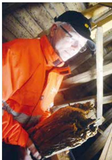
Ingemar Strömberg visar de ruttna bjälkarna i kyrktornet.
