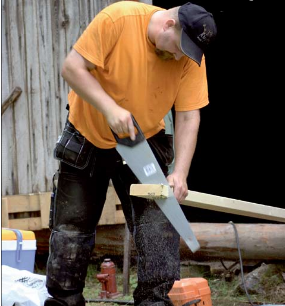
Jens Enkvist, Åbyns bygg, i full färd med att sätta in nya golvåsar i den gamla vedboden.
