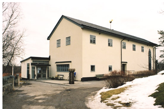
Exteriör från nordväst med kyrkans nya huvudentré i tillbyggnaden t v .
