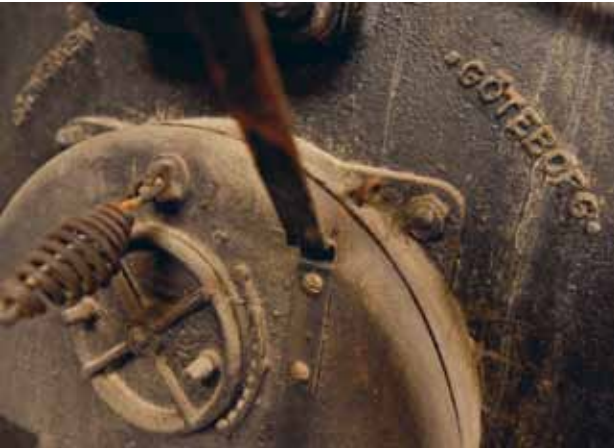
Den gamla uttjänta oljepannan från Götaverken i Göteborg byts nu ut mot modern bergvärme.
