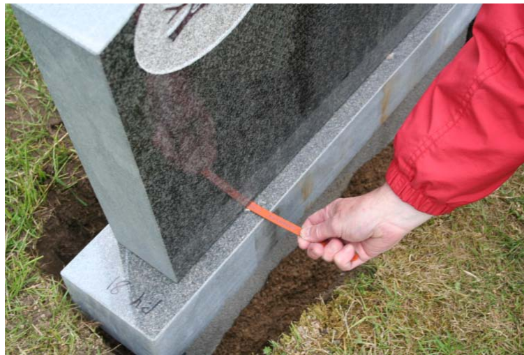
Figur 8. Kontroll av antalet dubbar med bågfilmsblad
