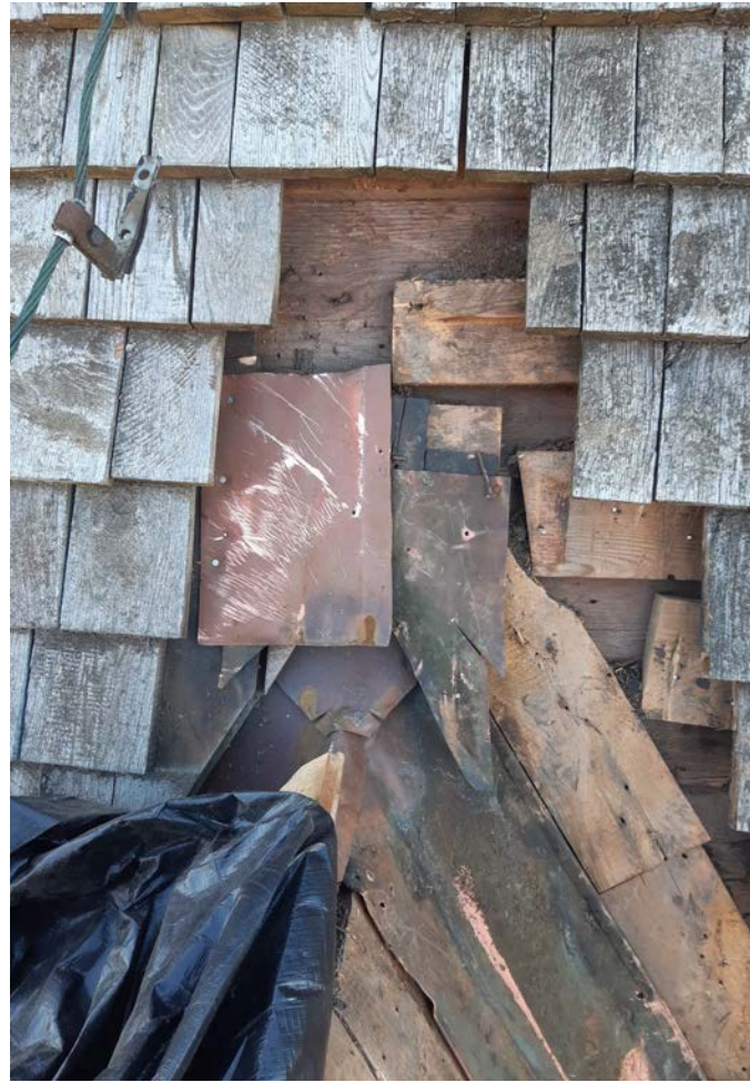
Fig. 43 Lapptäcke av småplåtar vid sakristians nock.
