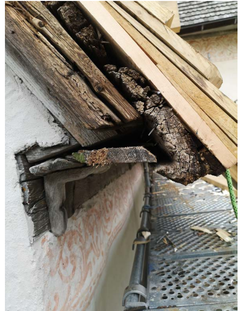
Fig.48 Bild på takfotskonstruktionen.
