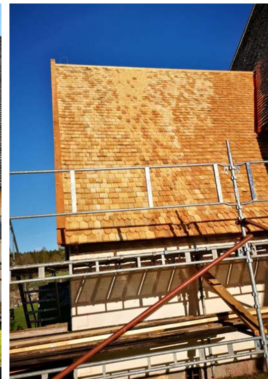
Fig. 71 Västra sidan med nylagt spån.
