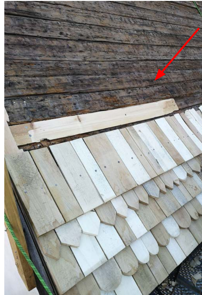
Fig. 53 Lagning på plats.
