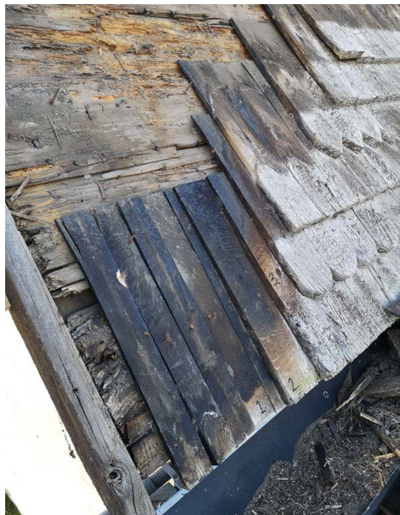
Fig. 38 De tre första 3 lagren var alla i fullängd (som på östra sidan). Utstick över takfot ca. 50 mm.
