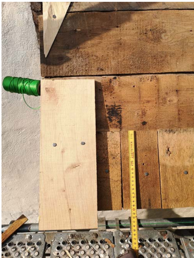
Fig. 25 Visar det understa lagret spån spikade kant i kant med takfoten. Spånen återanvändes från det tidigare taket, 200 mm långa och kapade från den övre delen av spånet. Bredvid syns lager 2 som är 370 mm långt.
