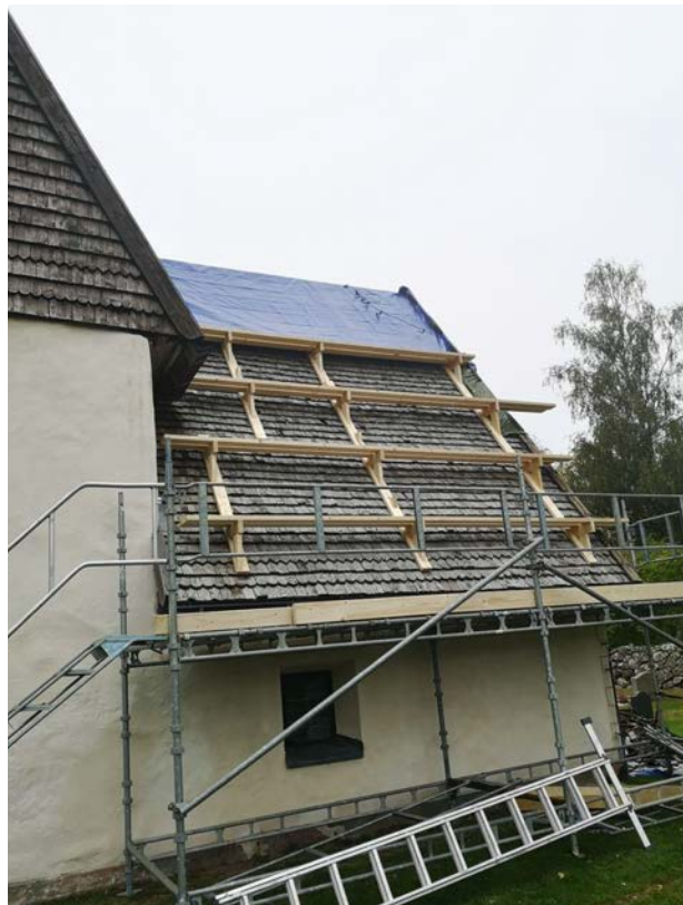
Fig.1 Visar Östra takfallet, ställning och konsoler är på plats inför fortsatt rivning.
